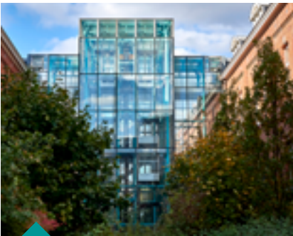
Incubateur du projet usquare.brussels Incubator van het usquare.brussels project
