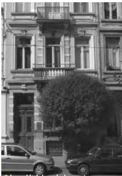
● Immeuble de la rue Lesbroussart
