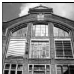
Le Bâtiment principal.
