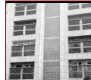
Balcons et vitrage rue François Dons.
