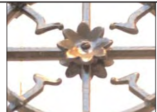
Détail du garde-corps
