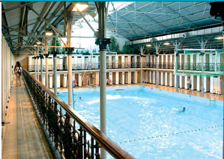
Vue de la piscine après rénovation
