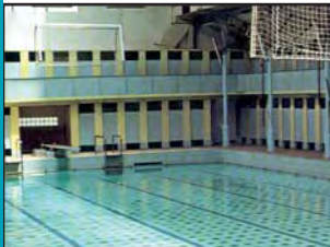
Vue de la piscine (années 1980)
